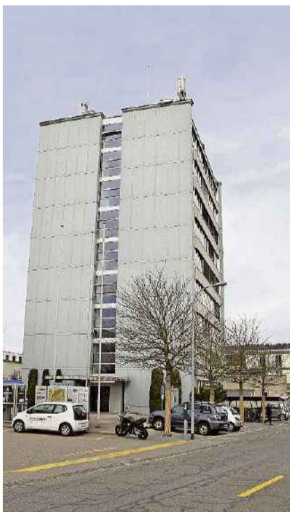
Neu werden die Parkplätze rund um das Gemeindehaus im Bereich Dohlenzelgstrasse durchnummeriert.
